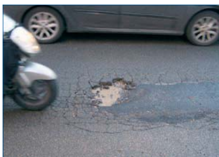
L'intervento tampone di un anno fa sta cedendo
