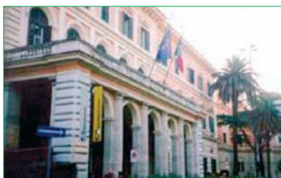
spiegato Marrazzo - entro marzo 2009 invece dovranno essere pronti i cunicoli intelligenti che prevedono la sistemazione di cavi e tubazioni sotto le gallerie. Dopo aver dimostrato che si potevano restaurare le gallerie della vergogna dobbiamo passare alla ristrutturazione di tutto il Policlinico, una struttura che, in alcuni punti, non viene ristrutturata da 40-50 anni».
