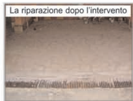
La riparazione dopo l'intervento
